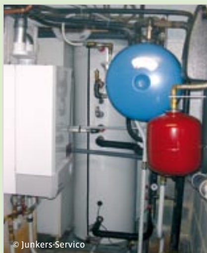
JUNKERS-SERVICO // HR TOP ketel + zonneboiler van 286 liter + zonnepanelen
