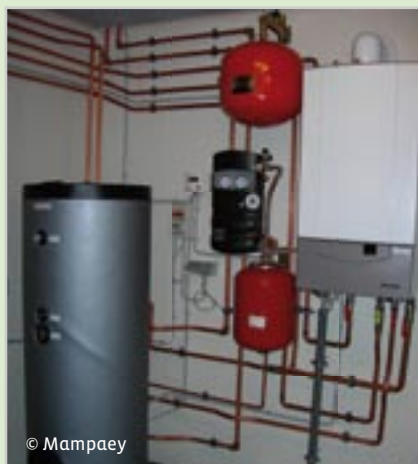
MAMPAEY // HR TOP ketel + zonneboiler van 300 liter + 3 zonnepanelen van elk 2 m 2
